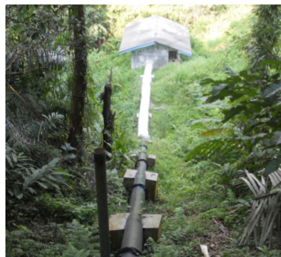
Gambar 7. Pembangunan Proyek PLTMH dengan Partisipasi Masyarakat
