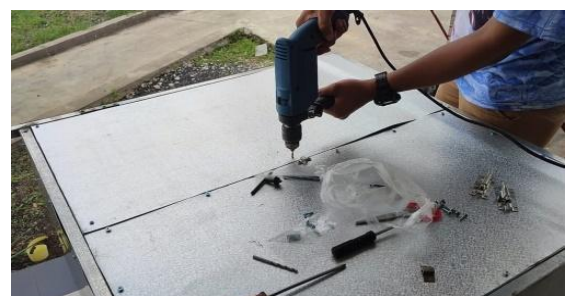
Gambar 4. Pemasangan plat galvalume sebagai permukaan oven Sumber: dokumen pribadi, 2022
